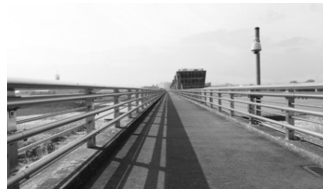
取水堰上部にかかっている管理用通路。これを利用して歩道にします。
