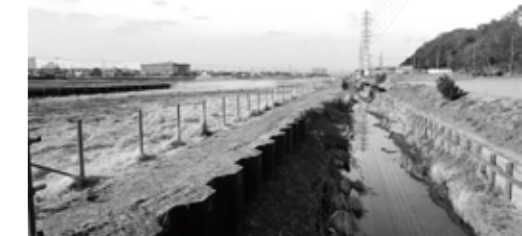
永池川。左の杭を打ってある土地が買収され、幅員26mの自然型河川に。
