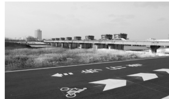
取水堰全景。すでに開通しているさがみグリーンライン（写真手前）と接続します。
